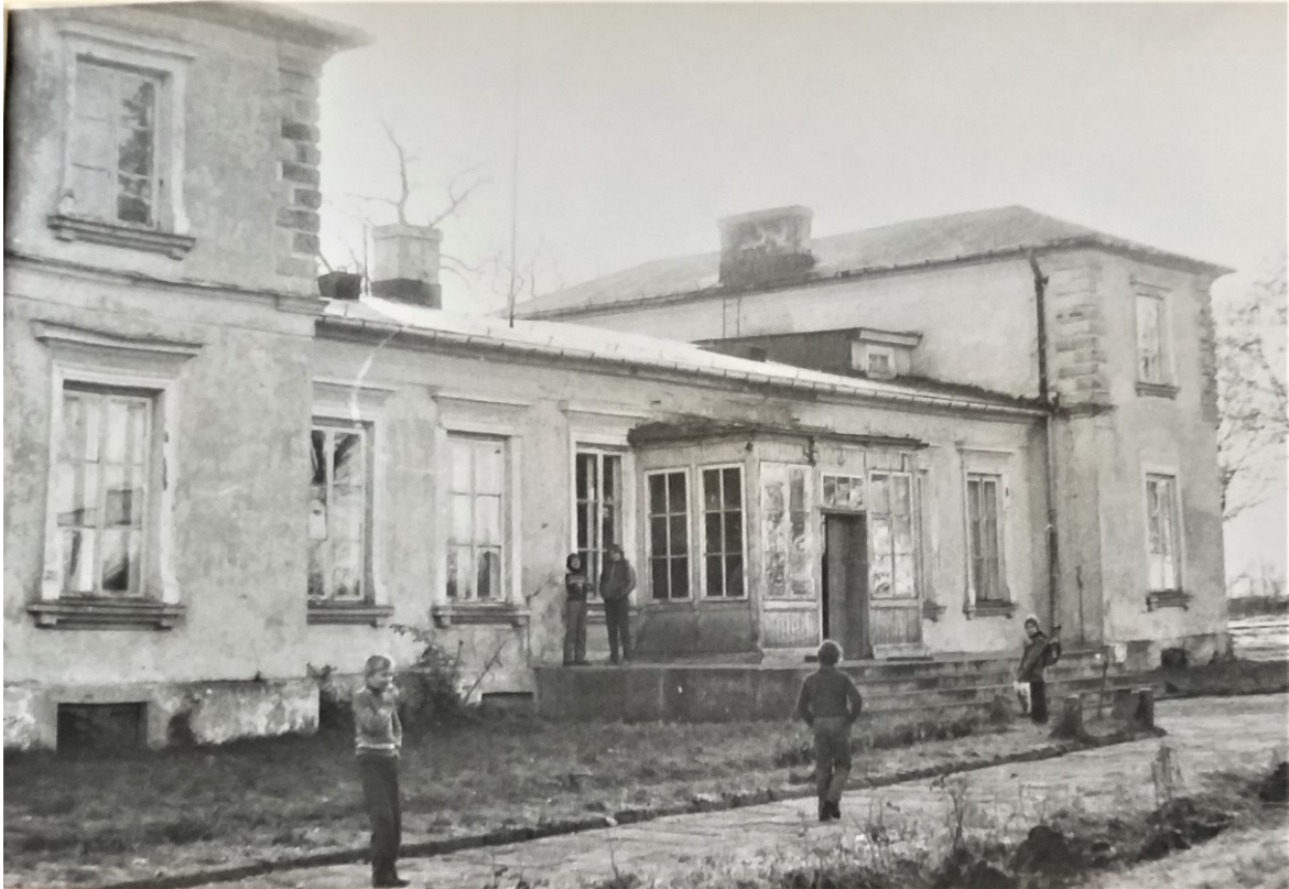
9. Widok dworu od strony zachodniej 1982 r.
