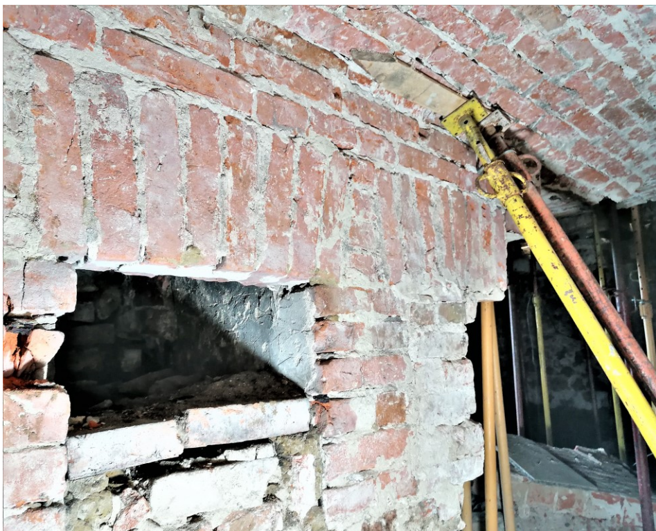
27. Środkowa część korytarza piwnic w przybudówce. Widoczne 2 wyczystki kominowe (prawy fragment urwany) we wschodniej ścianie korytarza.
