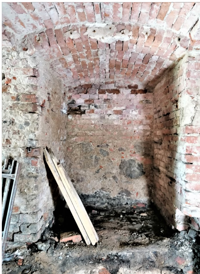
39. Północna część piwnic przybudówki, przy wejściu. Wnęka w korytarzu od strony wschodniej o niejasnej funkcji.
