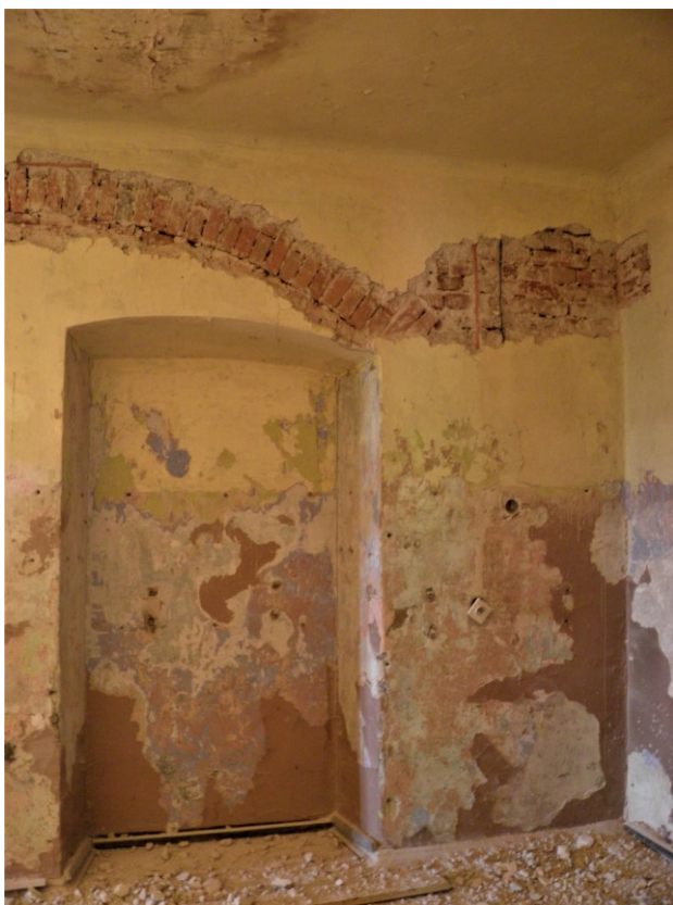
14. Ściana południowa w pomieszczeniu środkowym od zachodu, w przybudówce, przylegającym do skrzydła północnego.
