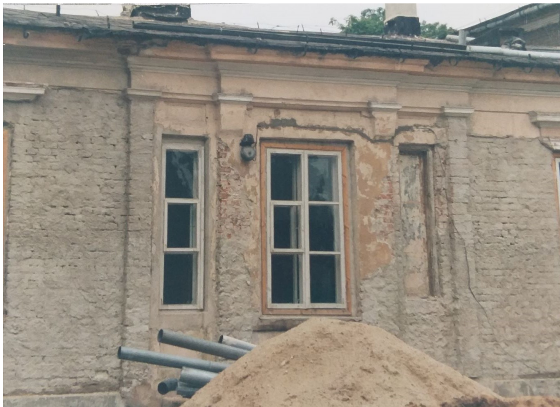
23. Widok dawnego wejścia do dworu od strony wschodniej po usunięciu tynków. Fot. A. Majewska-Rau, 1993 r.
