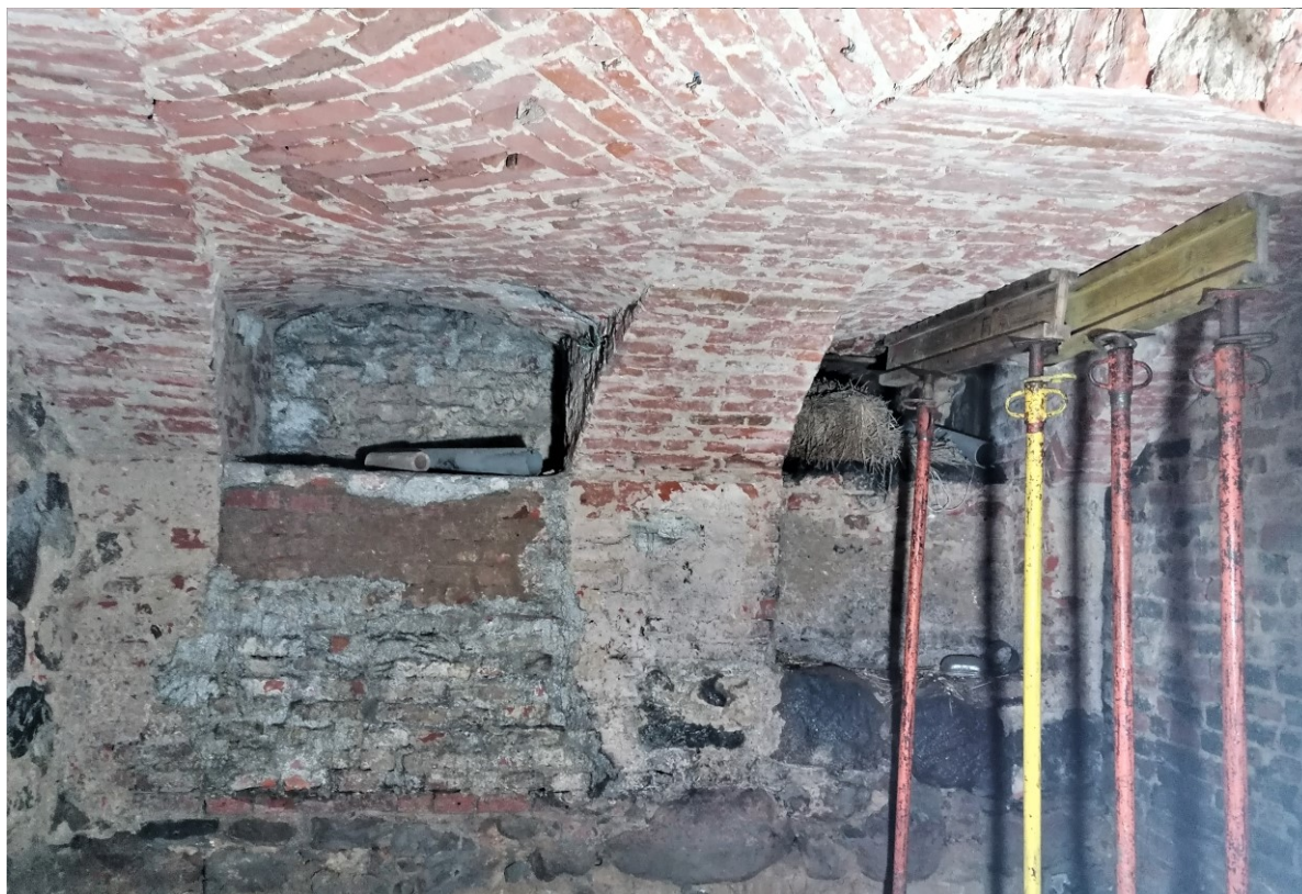
31. Piwnica, północno-wschodnia w przybudówce. Widoczny większy otwór, zamieniony na okienko, następnie zamurowany w całości, pod wejściem wschodnim do przybudówki.
