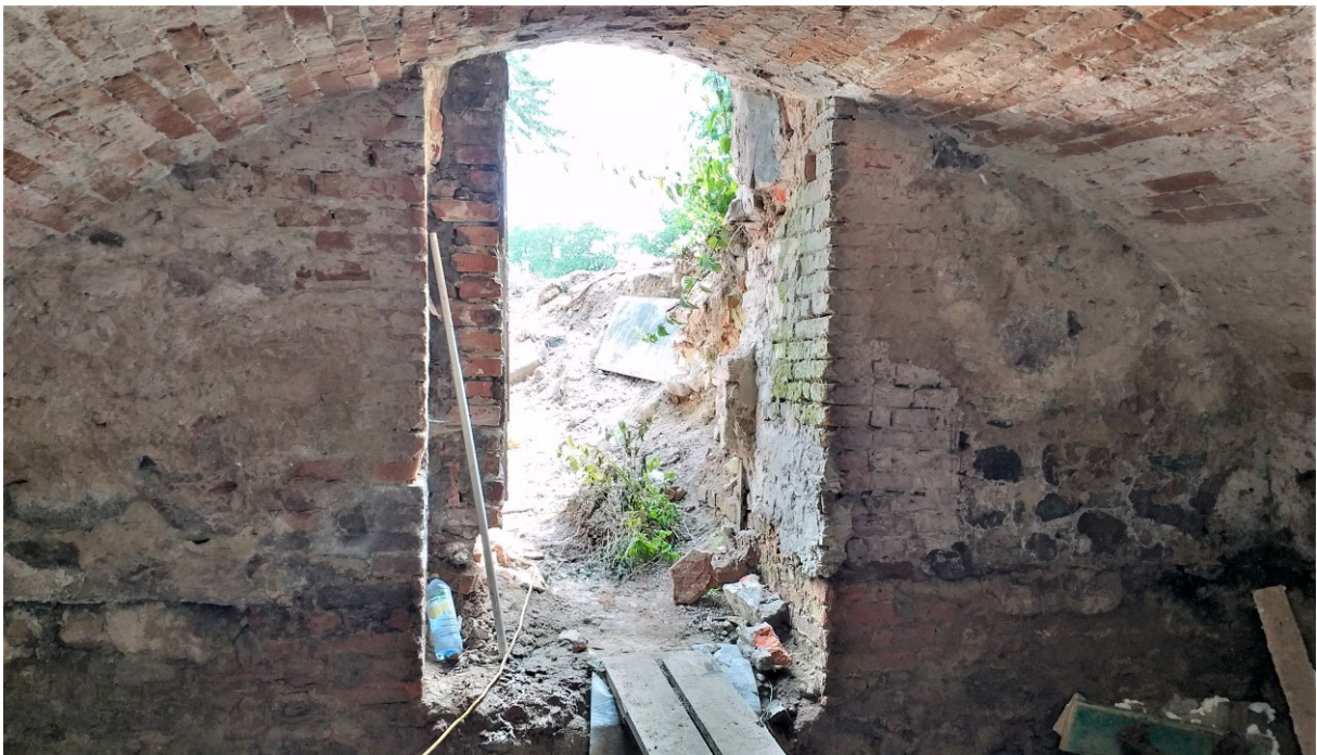
18. Wyjście z piwnic w środkowej części dworu.
