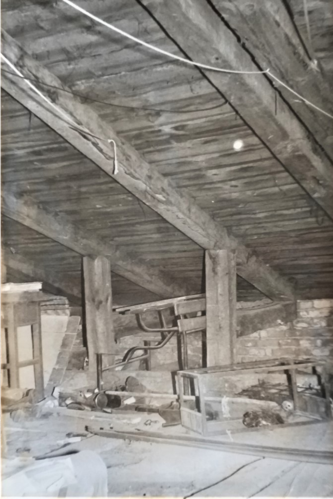
17. Wnętrze strychu w środkowej części dworu 1982 r.
