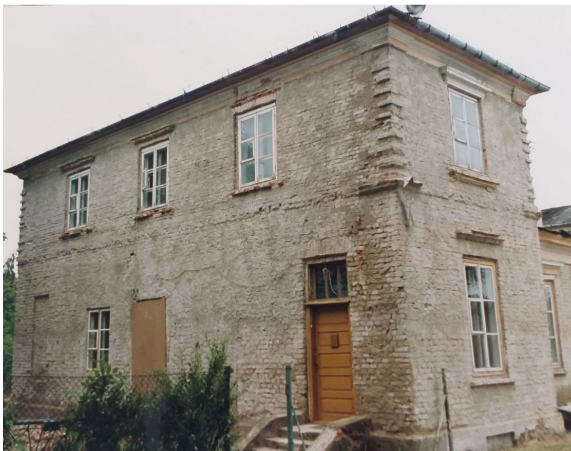
20. Widok elewacji południowej po usunięciu tynków. Fot. A. Majewska-Rau, 1993 r.
