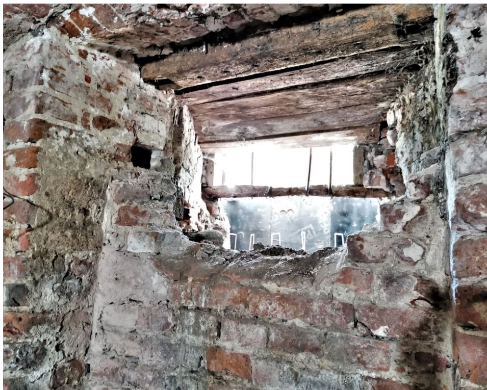
25. Południowo-zachodnia piwnica w przybudówce pod skrzydłem północnym. Przez pierwotne okienko widać dobudowaną ścianę zachodnią skrzydła północnego.
