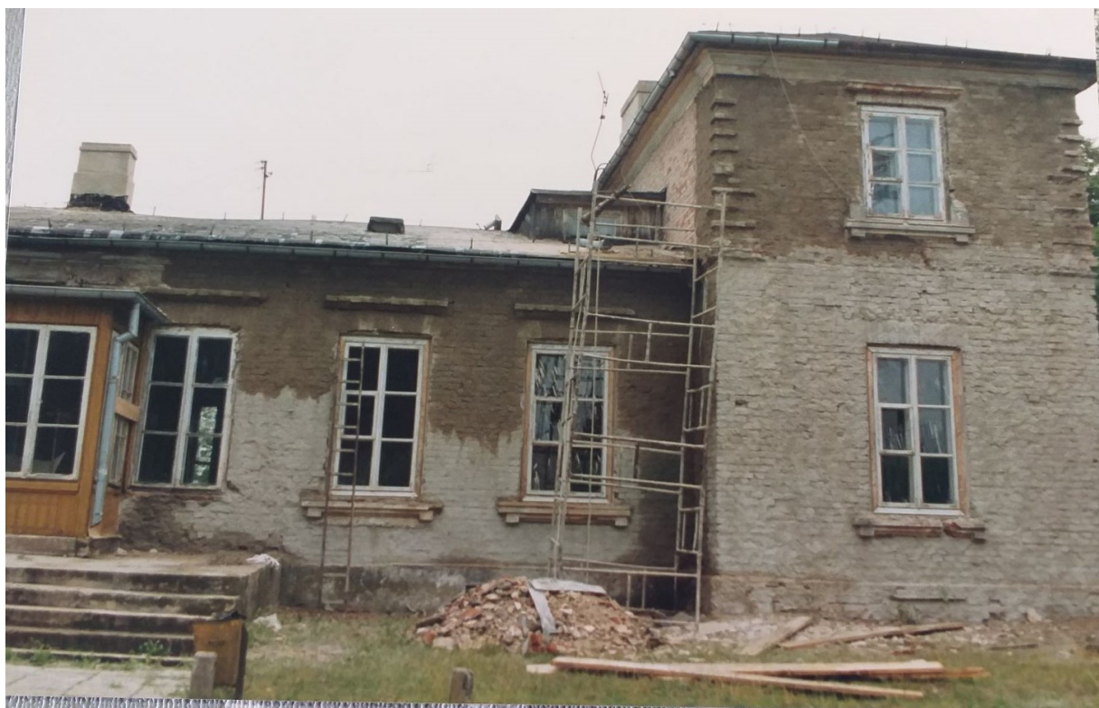
22. Widok dworu od strony zachodniej po usunięciu tynków. Fot. A. Majewska-Rau, 1993 r.
