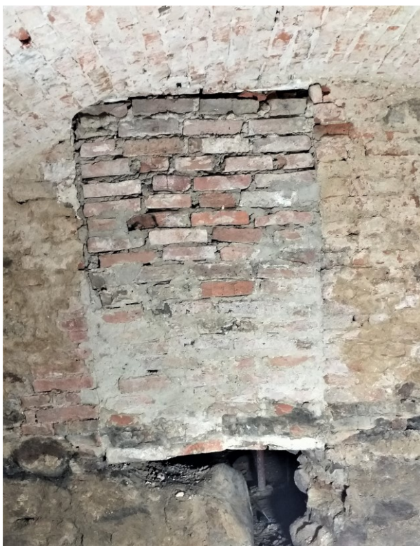
22. Piwnica północno-wschodnia w parterowej części dworu. Ściana północna, pierwotna ściana zewnętrzna. Widoczne zamurowane przejście do przybudówki.
