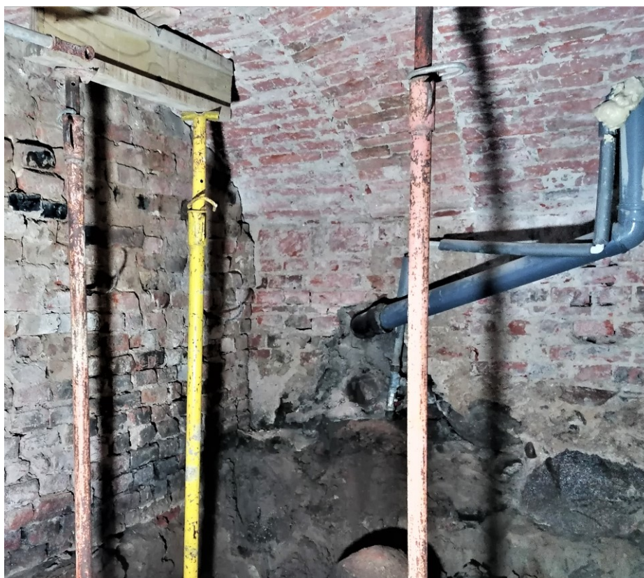
30. Piwnica południowo-wschodnia w przybudówce, narożnik północno-wschodni. Po lewej stronie widoczna wtórna ściana. Po prawej stronie ściany widoczny ślad pierwotnej ściany.
