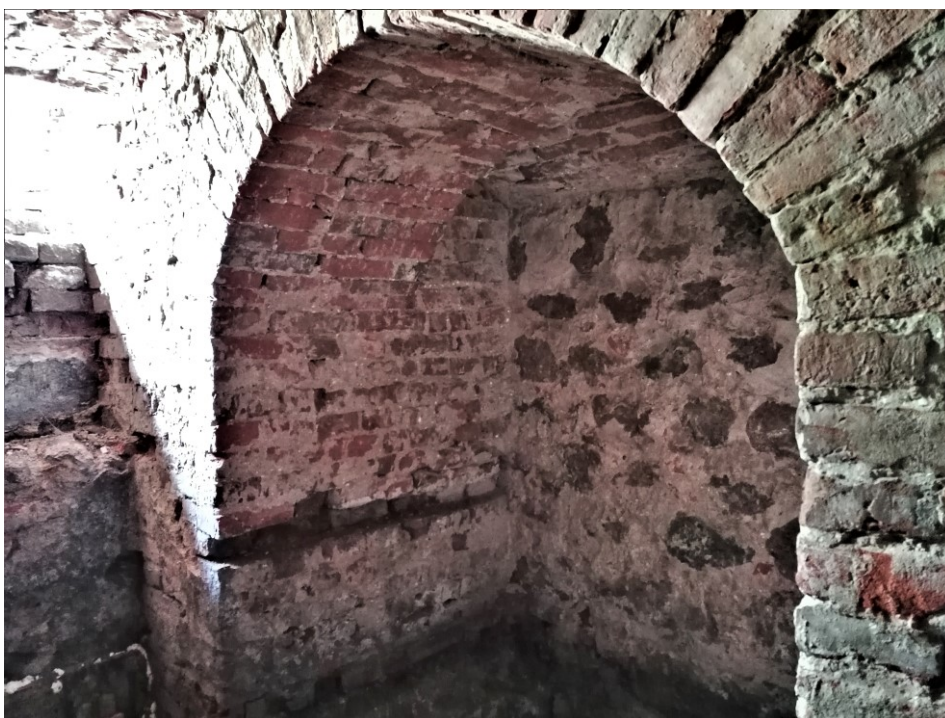
24. Wnęka w południowo-zachodnim łączniku w piwnicy w przybudówce, z arkadą wspierającą ścianę skrzydła północnego.
