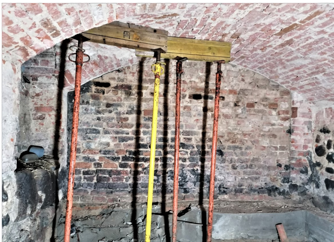
32. Piwnica, północno-wschodnia w przybudówce. Wtórna ściana południowa.
