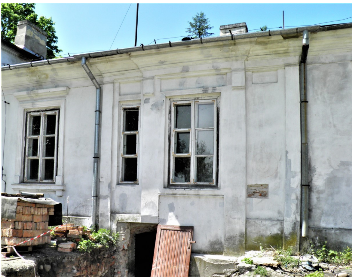
2. Widok środkowej części dworu w elewacji wschodniej. Dawne wejście główne.
