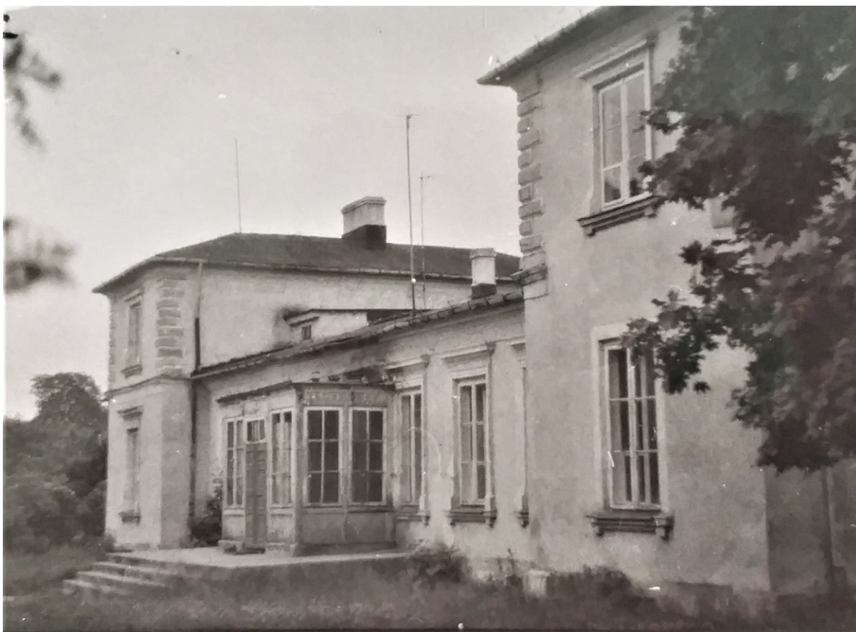
8. Widok dworu od strony zachodniej 1980 r.
