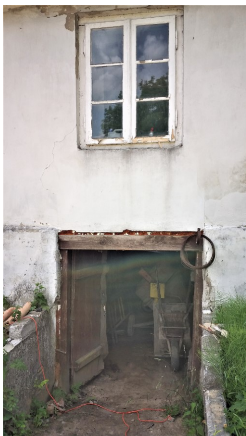
8. Zejście do piwnicy w elewacji północnej.
