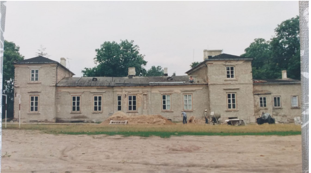
18. Widok dworu od strony wschodniej po usunięciu tynków. Fot. A. Majewska-Rau, 1993 r.
