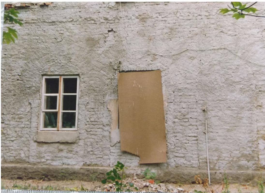
25. Widok dworu od strony południowej po usunięciu tynków. Fot. A. Majewska-Rau, 1993 r.
