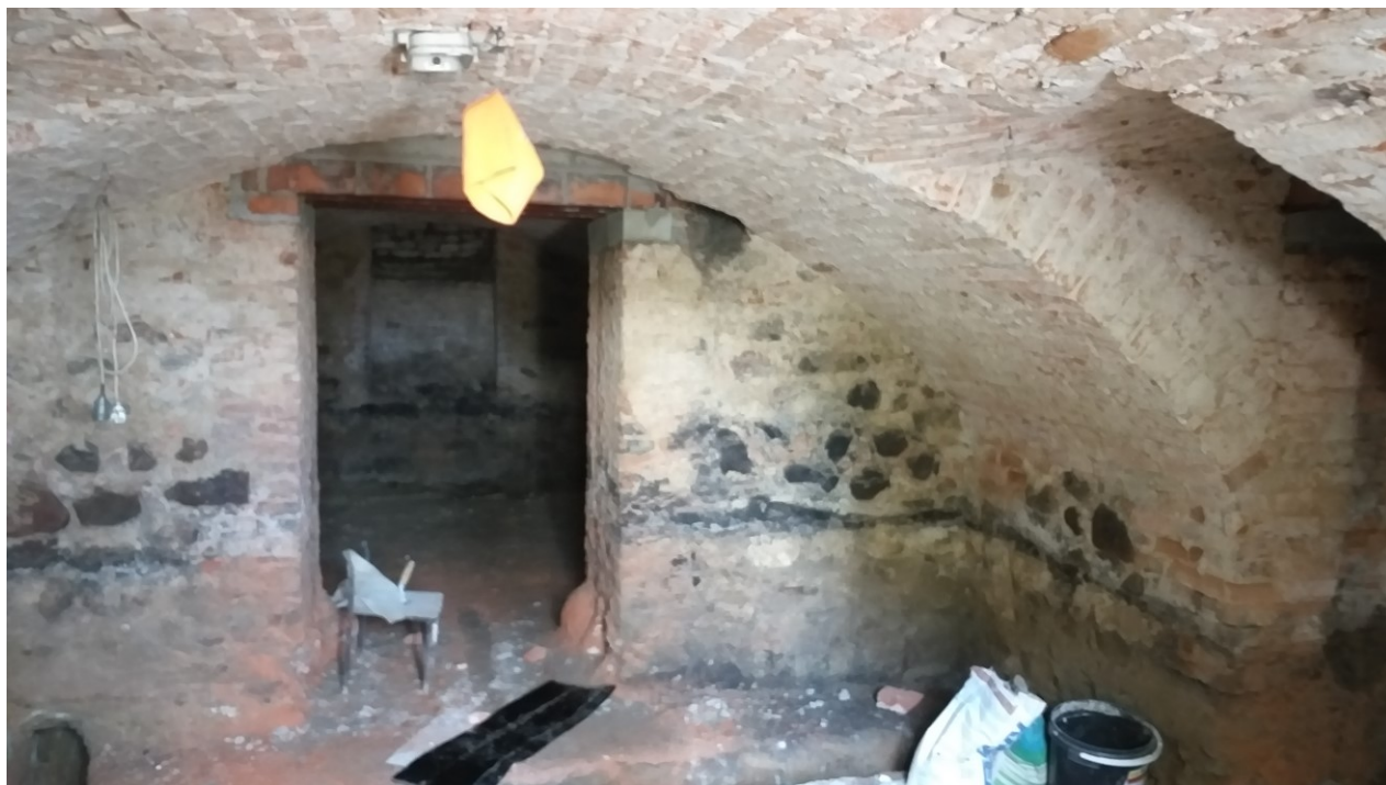
19. Wnętrze środkowej piwnicy w parterowej części dworu.
