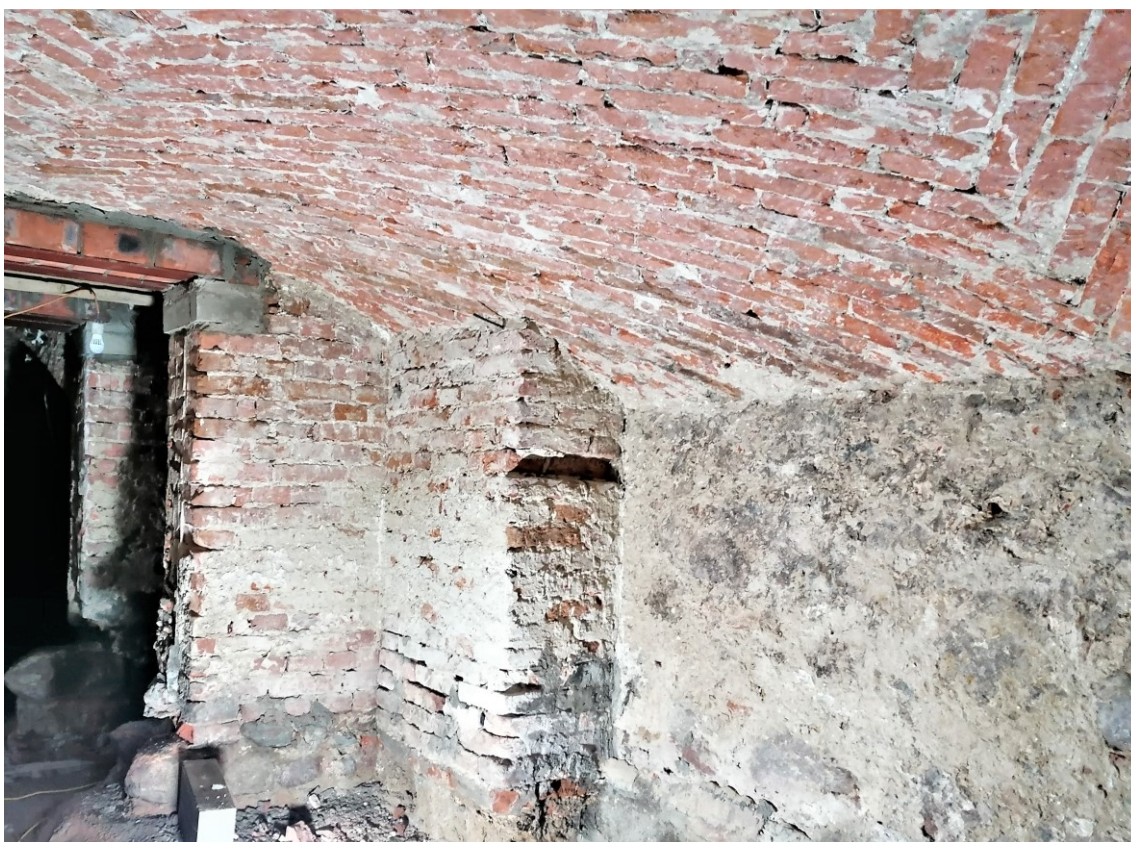
36. Śródkowa, zachodnia piwnica w przybudówce. Narożnik południowo-wschodni. Widoczny słup wzmacniający ścianę skrzydła północnego.
