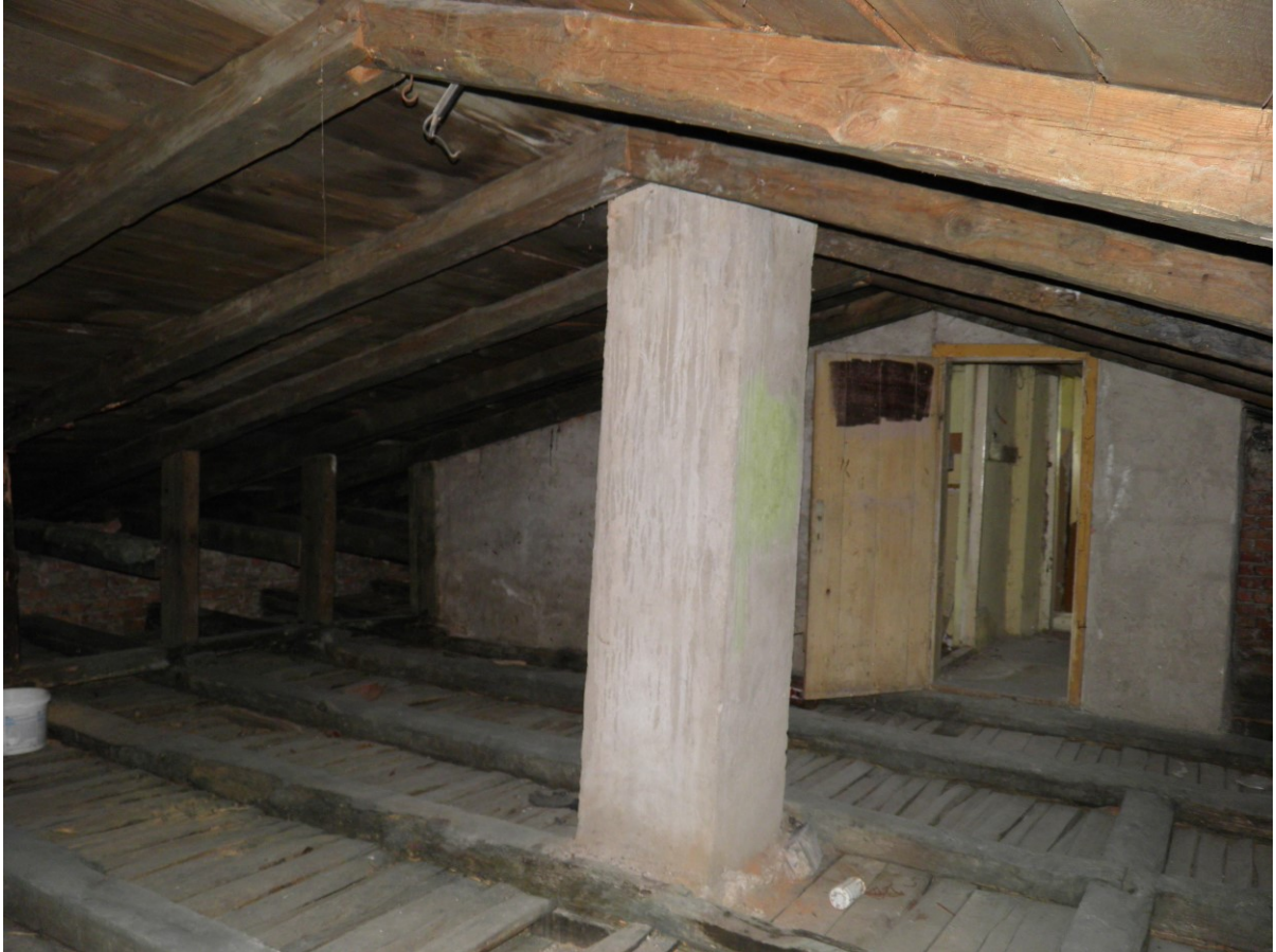
17. Wnętrze strychu nad częścią środkową dworu.
