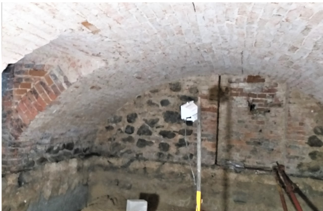
20. Piwnica południowo-wschodnia w parterowej części dworu. Ściana południowa, pierwotna ściana zewnętrzna. Widoczne zamurowane okienko.
