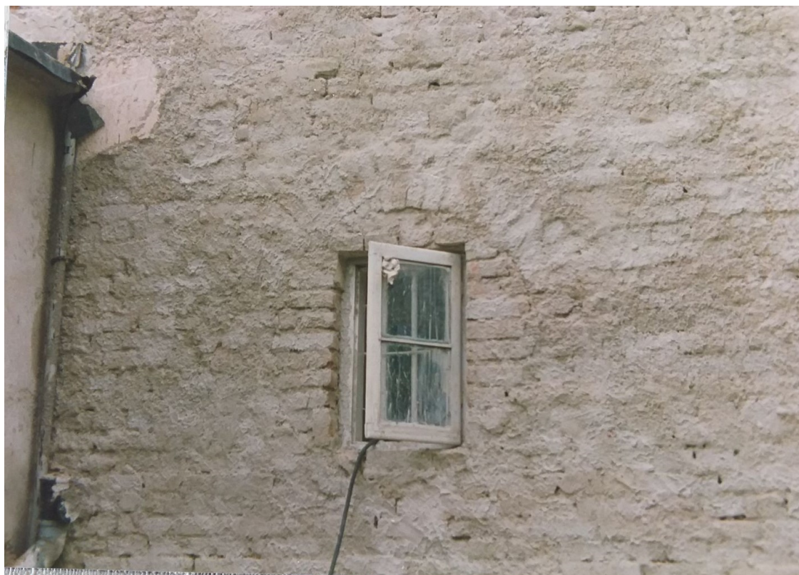
24. Widok dworu od strony północnej po usunięciu tynków. Fot. A. Majewska-Rau, 1993 r.
