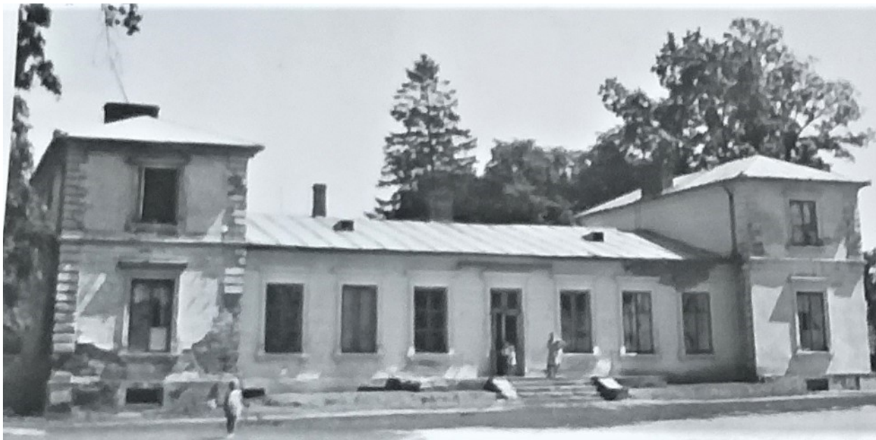
7. Widok dworu od strony zachodniej 1966 r.
