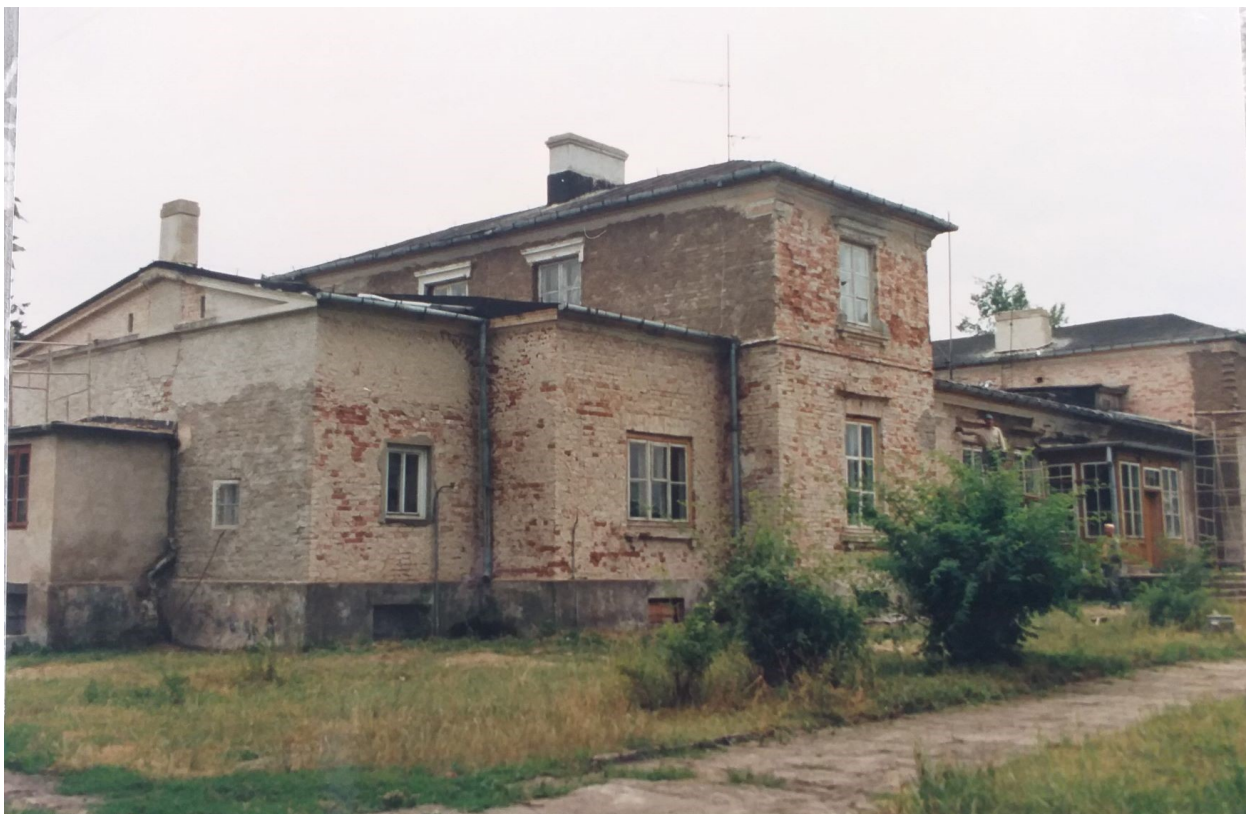
19. Widok dworu od strony zachodniej po usunięciu tynków. Fot. A. Majewska-Rau, 1993 r.
