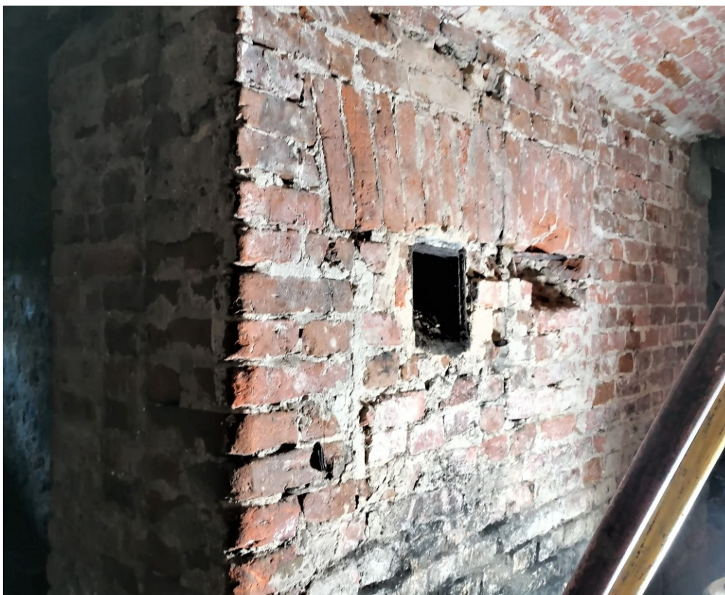
28. Środkowa część korytarza piwnic w przybudówce. Widoczne 2 wyczystki kominowe (częściowo zamurwane) w zachodniej ścianie korytarza.
