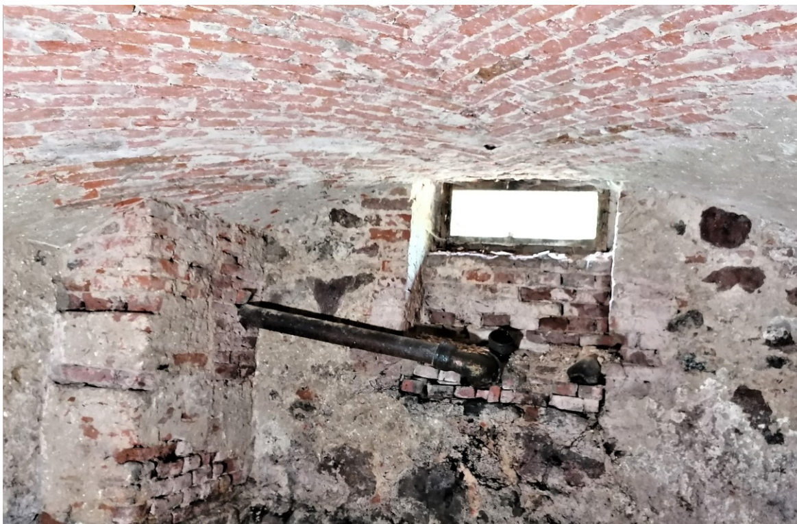
35. Śródkowa, zachodnia piwnica w przybudówce. Ściana zachodnia. Po lewej stronie widoczny słup wzmacniający pod ścianą skrzydła północnego.
