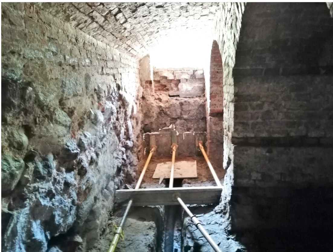
23. Południowo-zachodni łącznik w piwnicy w przybudówce, pomiędzy środkową i północną częścią dworu. Po lewej stronie widoczna ściana łącząca się z pierwotną, zewnętrzną ścianą środkowej części dworu. Po prawej stronie widoczne arkady wspierające ścianę skrzydła północnego.
