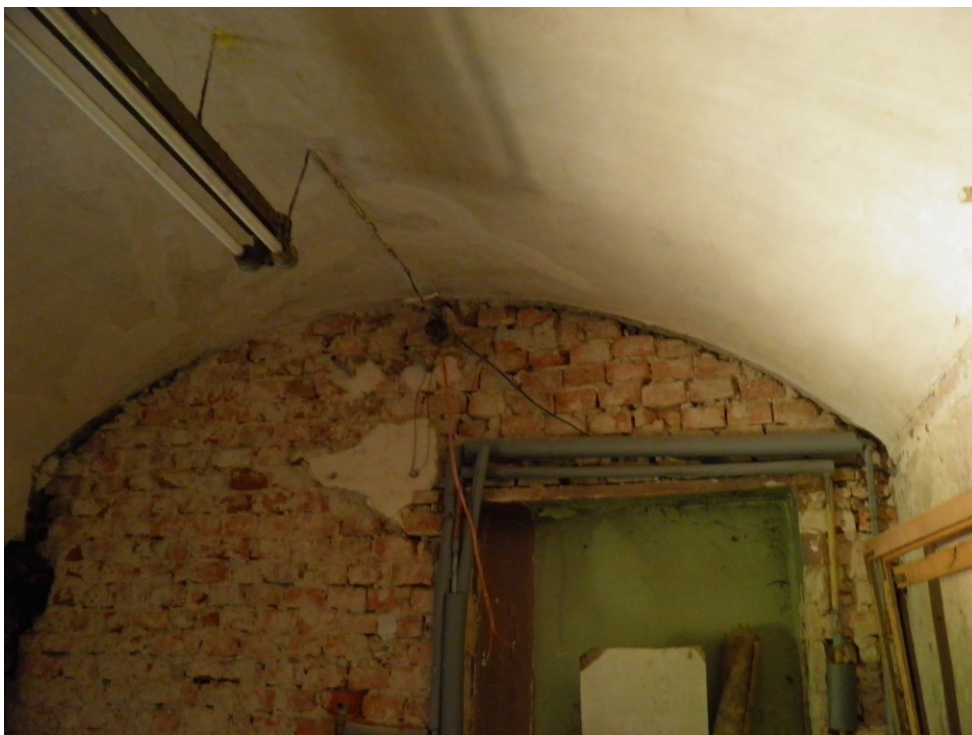
15. Ściana wschodnia w skrajnym pomieszczeniu północno-zachodnim w przybudówce.
