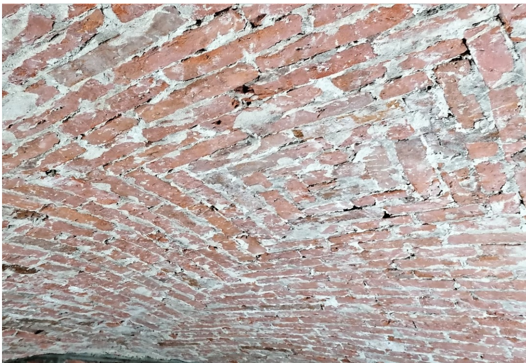
33. Pozorne sklepienie krzyżowe w środkowej piwnicy zachodniej w przybudówce.
