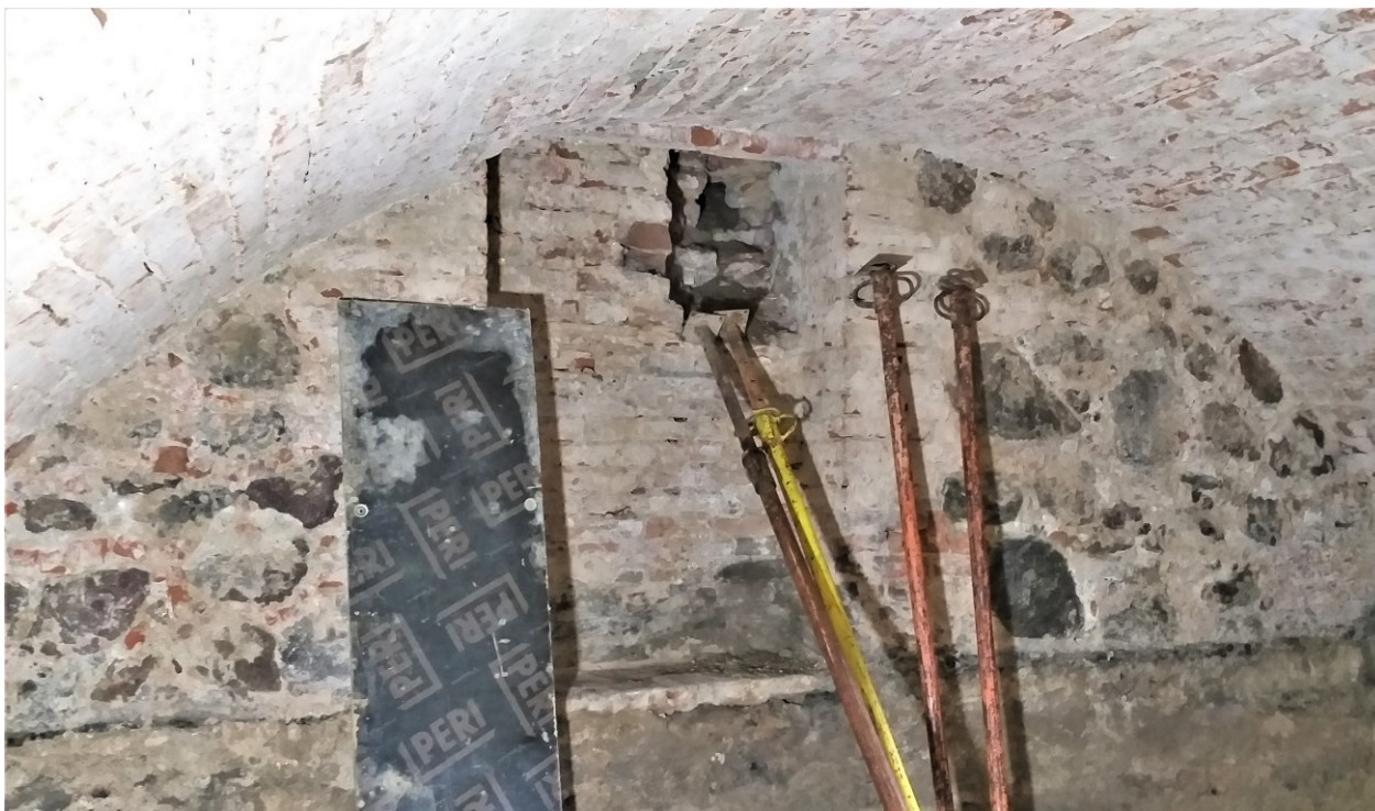
21. Piwnica południowo-zachodnia w parterowej części dworu. Ściana południowa, pierwotna ściana zewnętrzna. Widoczne zamurowane okienko lub wyczystka komina (ślady popiołu).
