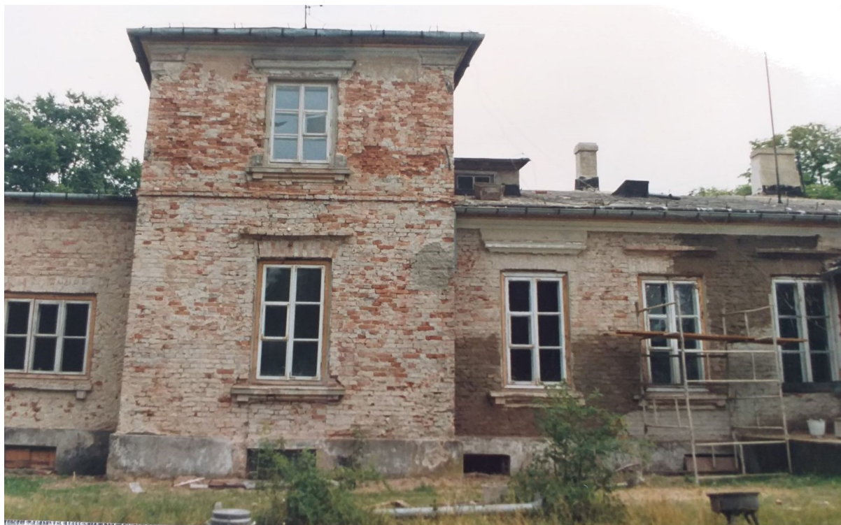
21. Widok dworu od strony zachodniej po usunięciu tynków. Fot. A. Majewska-Rau, 1993 r.
