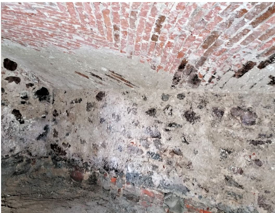
34. Środkowa, zachodnia piwnica w przybudówce. Ściana północna (pierwotnie zewnętrzna?) oddzielająca skrajną piwnicę północno-zachodnią. Widoczny sposób oparcia sklepienia na wyniesionej ścianie.
