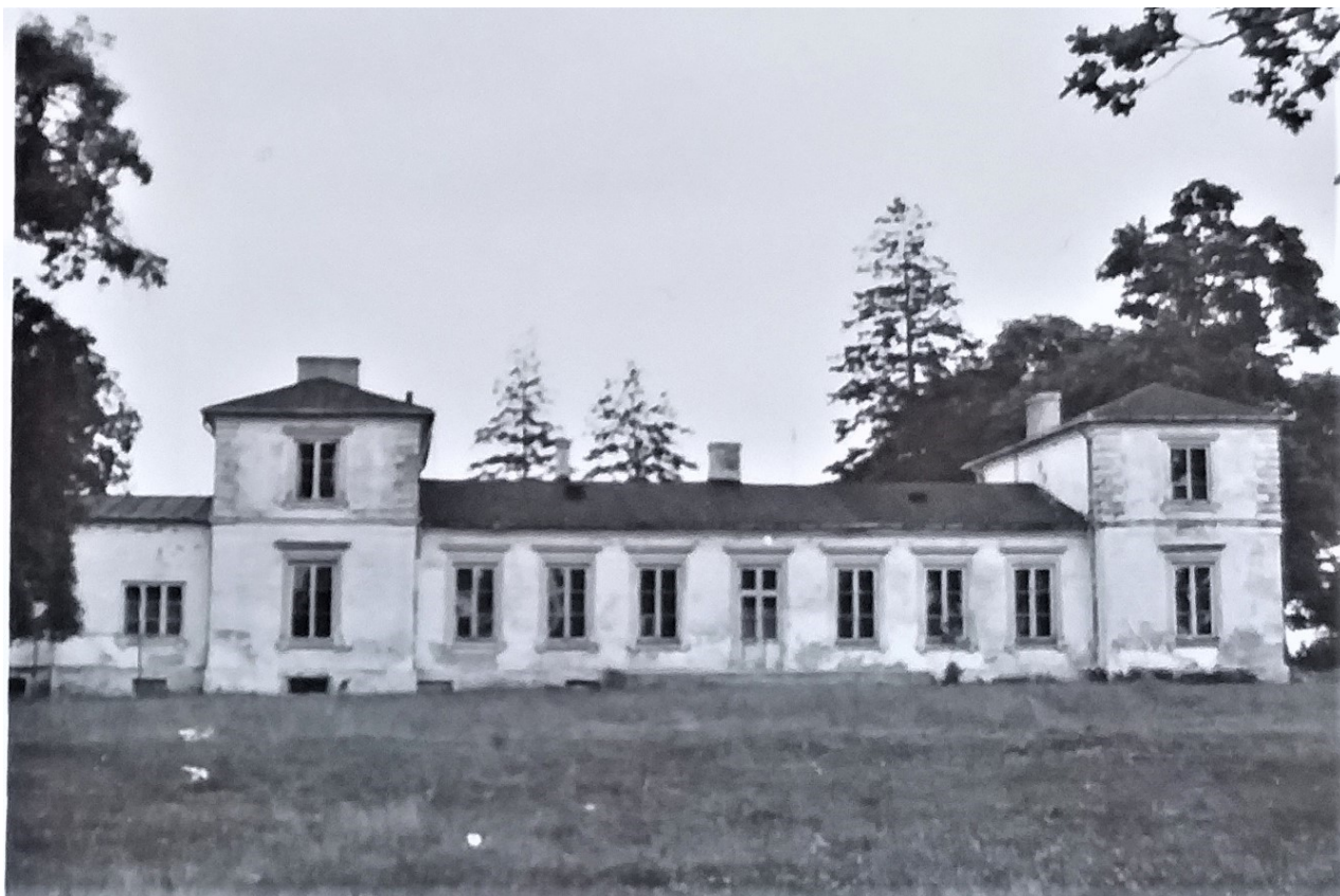
5. Widok dworu od strony zachodniej 1957 r.
