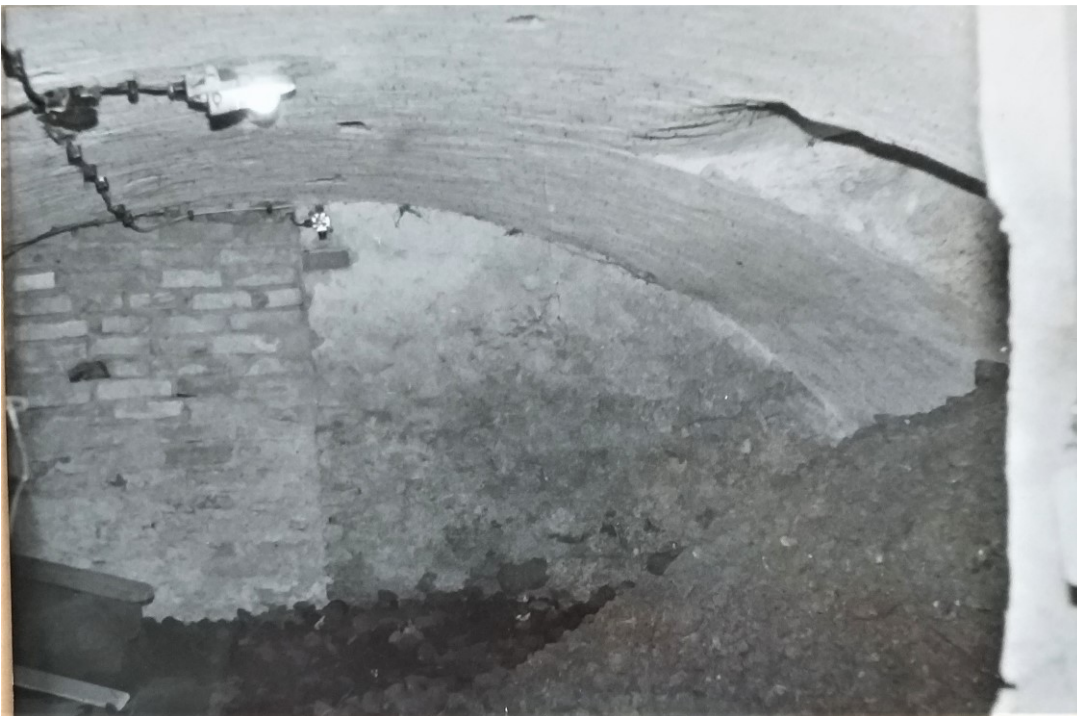
16. Widok z jednej z piwnic w środkowej części dworu 1982 r.
