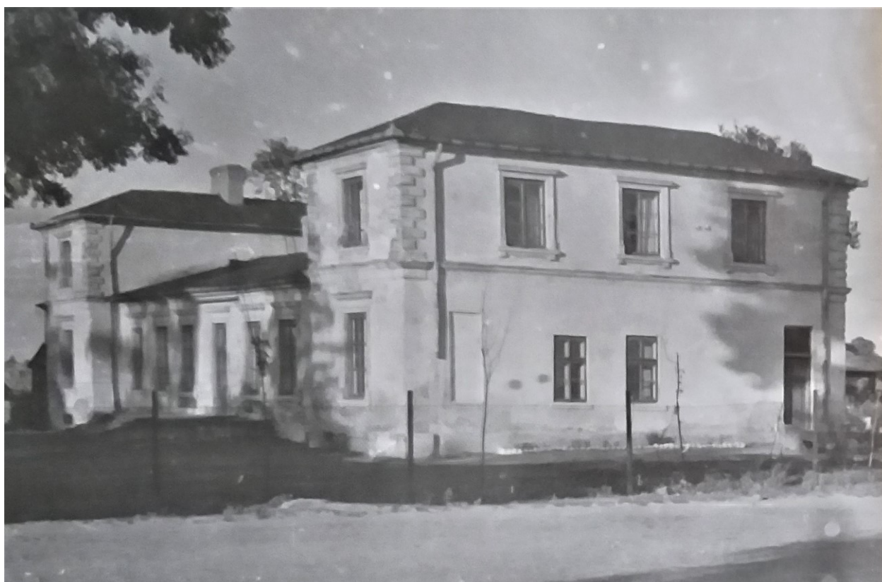
6. Widok dworu od strony zachodniej 1959 r.
