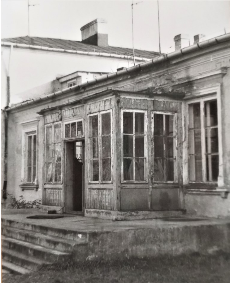
11. Widok dworu od strony zachodniej, ganek 1982 r.
