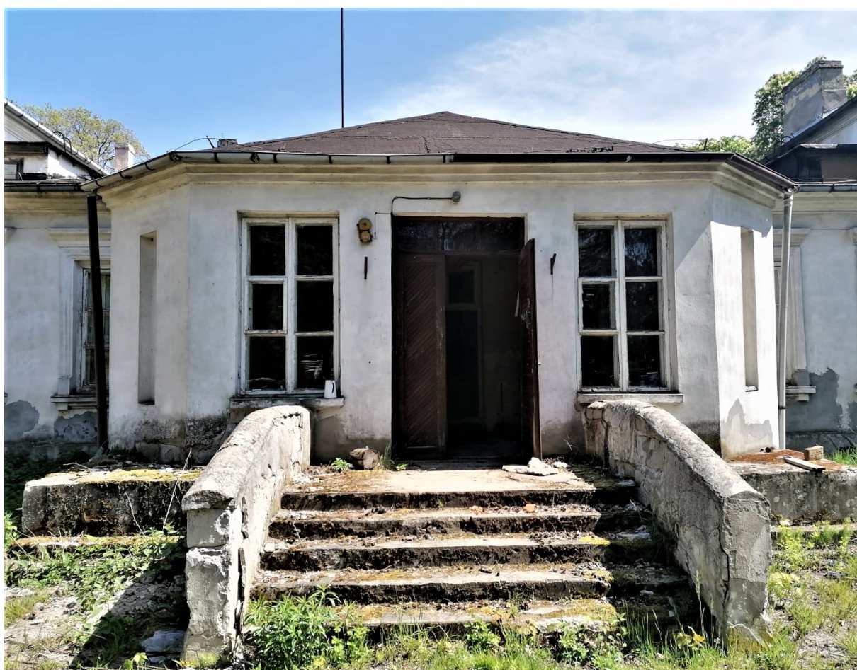
4. Współczesny ganek przy elewacji zachodniej dworu.
