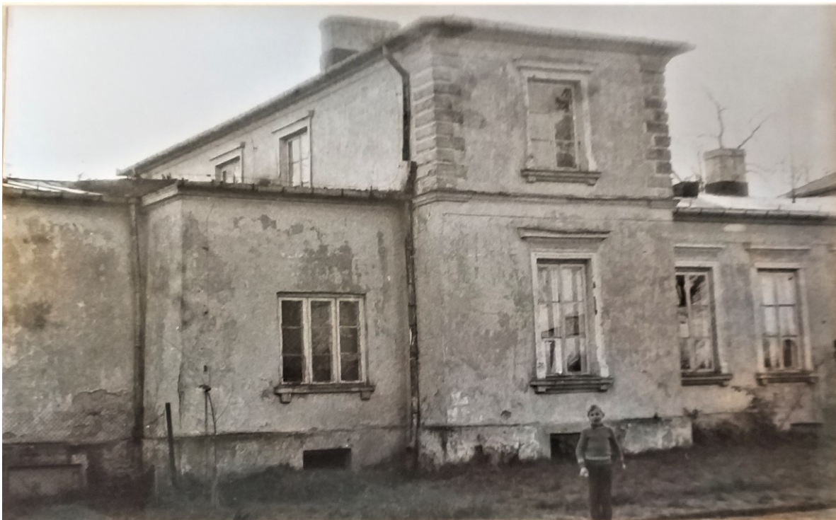
10. Widok dworu od strony zachodniej. Fragment północny 1982 r.
